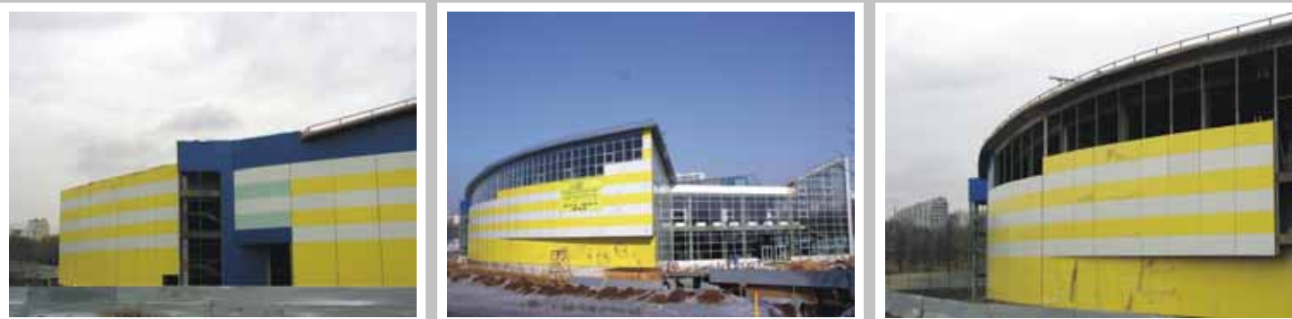
Торговый комплекс г. Москва
