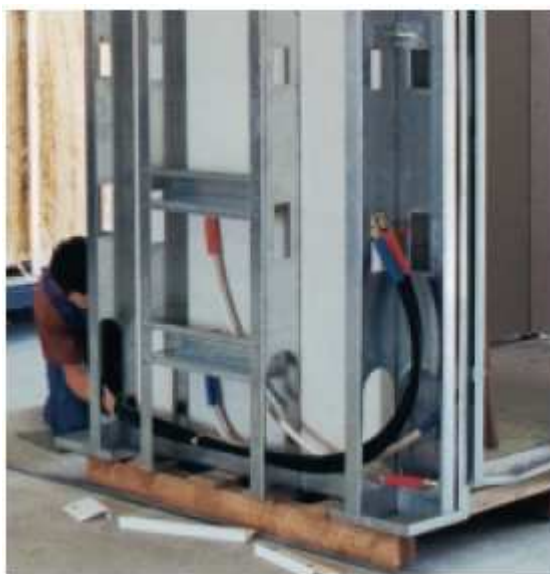
Рис. 28: В ходе электромонтажных работ в стальных профилях проделывают отверстия
