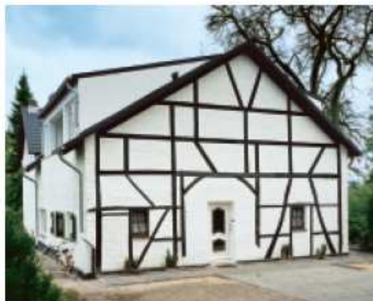
Надстройка исторического фахверкового дома в Динслакене (компания Rasta-Haus, г. Везель)
