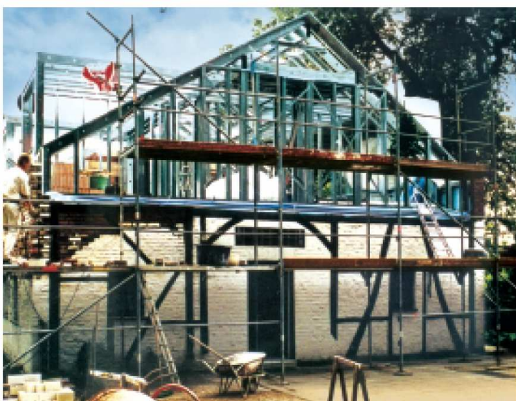
Рис. 8: Надстройка фахверкового дома 17 века. По причине ограничений веса сооружения использование ЛСТК было единственно возможным решением.
