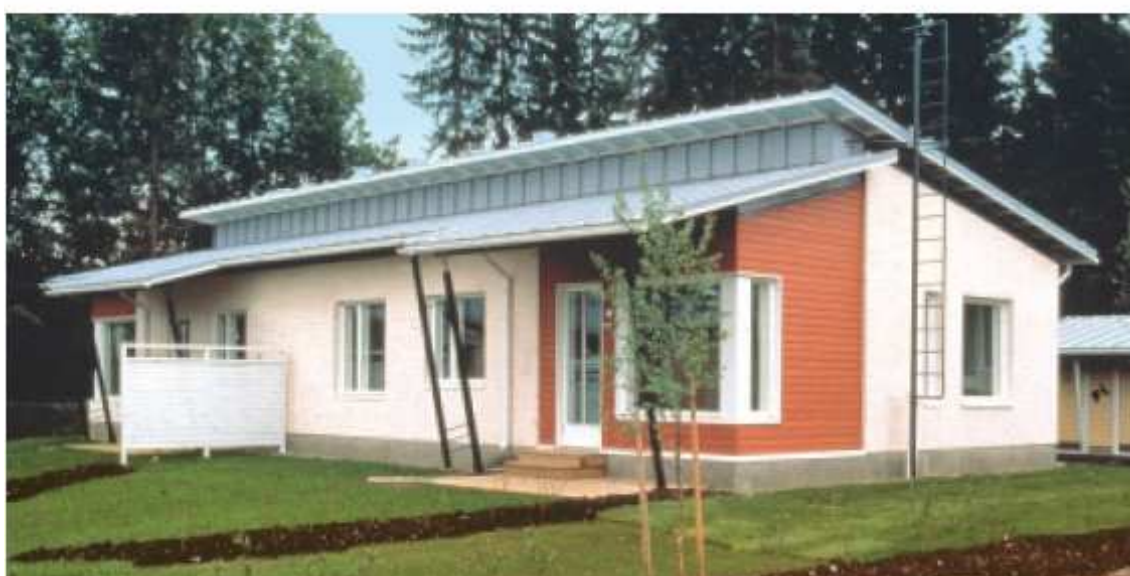
Рис. 2, 3, 4: Здания из легких стальных конструкций в процессе строительства и в готовом виде
