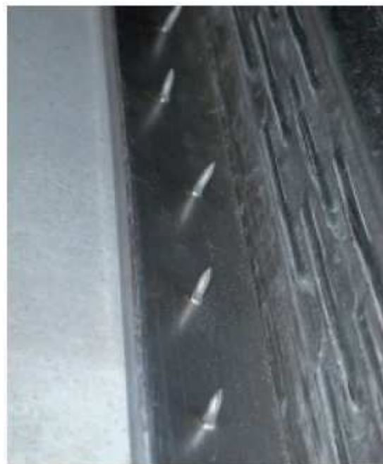
Рис. 48 - Пневматическое соединение дюбелей в стальные профили
