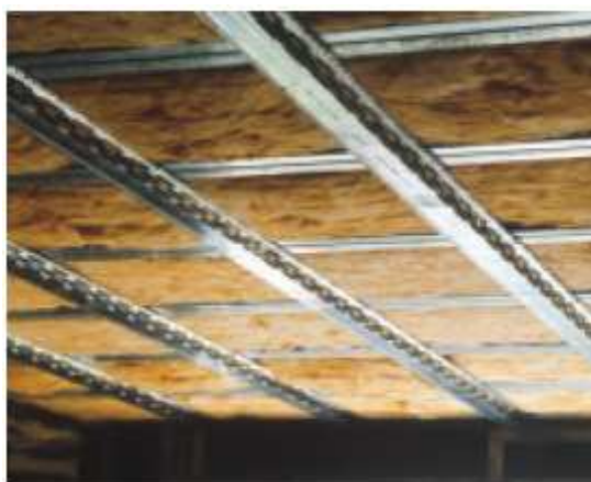
Рис. 56 (вверху): Использование шумоизолирующих профилей снизу балок в качестве звукоизоляционного компонента подвесного потолка
