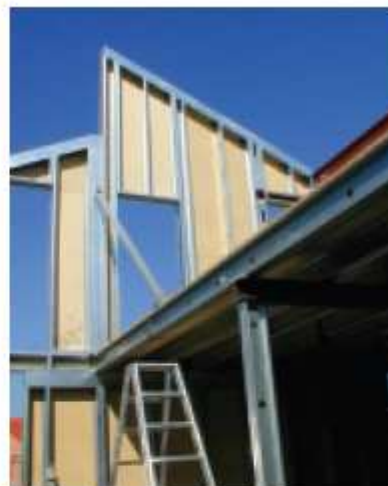
Односемейный дом в Бёбингене/Ремс (компания SwitchHaus, г. Бопфинген)
