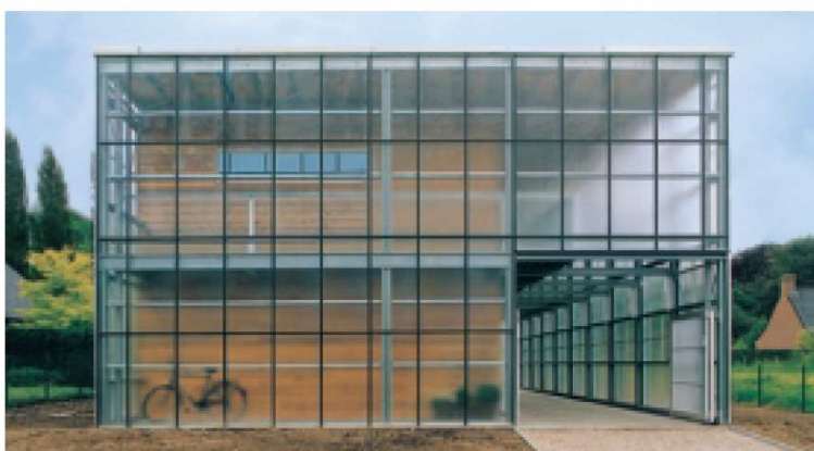
Рис. 5, 6, 7: Здания из легких стальных конструкций, каркас которых оставили открытым
