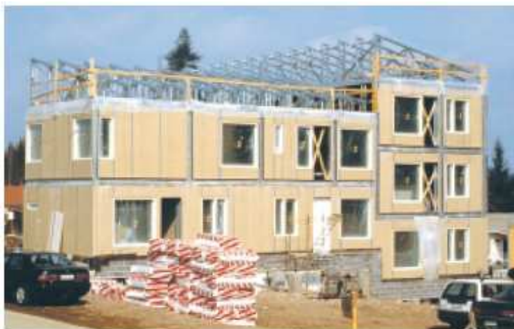
Рис. 30, 31 (внизу): Здание, построенное из сборных легких стальных конструкций
