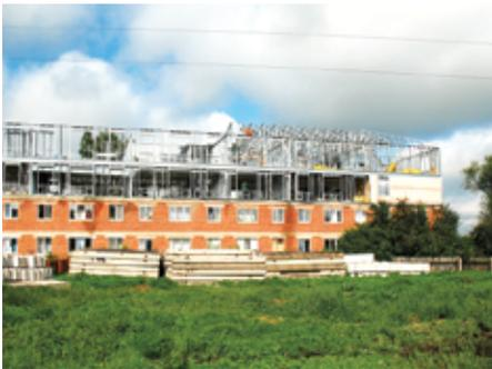
**Проект № 3.** Надстройка двух дополнительных этажей над существующим двухэтажным кирпичным жилым домом в г. Серебряные Пруды. Площадь надстройки – 1200 м<sup>2</sup>. Срок монтажа – 6 месяцев. Каркас выполнен из ЛСТК. Работы выполнялись без отселения жильцов. Дополнительно утеплены 1-2-й этажи с заменой оконных блоков.
