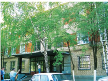
**Проект № 4.** Одноэтажная надстройка на существующее трехэтажное кирпичное здание в г. Арзамасе. Дополнительно выполнены работы по утеплению всего здания и монтаж вентилируемого фасада с применением стальных фасадных кассет и профилированного листа. Работы выполнены за 4,5 месяца.
