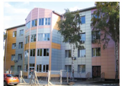
влиянию биологических и влажностно-температурных процессов, в отличие от древесины. Время эксплуатации зданий определяется в основном сроком службы металлокаркаса, плитных материалов обшивки, утеплителя. При использовании ЛСТК, профили которых изготавливаются из оцинкованной стали с нормой расхода цинка 275 г/м<sup>2</sup> с учетом естественной эмиссии цинка, время жизни конструкций составляет порядка 100 лет (согласно исследованию British Steel).
